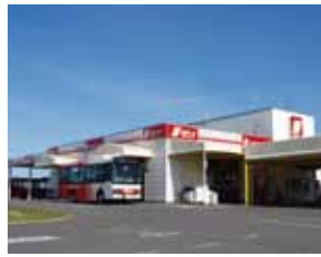
(3) Bürogebäude eines Mietwagenanbieters
